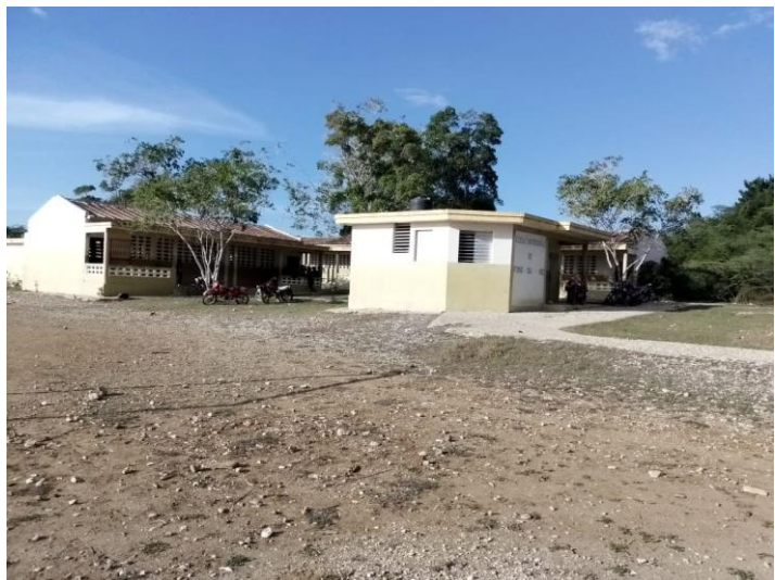
Figure 3 : Site d’implantation de l’abri
